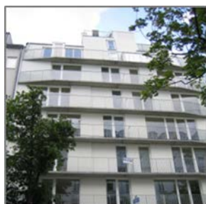
Wien 5 Fendigasse 27 Wohnungen: 43 – 65 m 2 Fertigstellung: 06/2009
