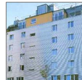
Wien 20 Leipziger Straße 58 Wohnungen: 36 – 65 m 2 Fertigstellung: 06/1998
