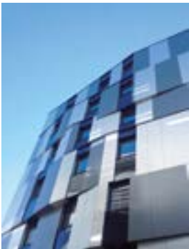
5020 Salzburg (Auszug) Wohn- u. Geschäftsgebäude Gaswerkergasse 9
