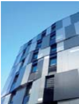
5020 Salzburg (Auszug) Wohn- u. Geschäftsgebäude Gaswerkergasse 9
