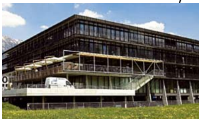
6020 Innsbruck (Auszug) Büro- und Geschäftsgebäude „SOHO“
